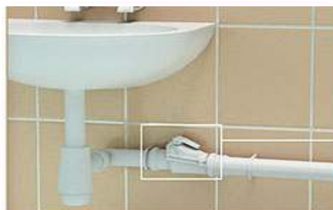
Παράδειγμα τοποθέτησης βαλβίδας ZB50 Μοντέλο Α
