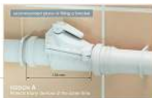
Παράδειγμα τοποθέτησης βαλβίδας ZB50 Μοντέλο Α
